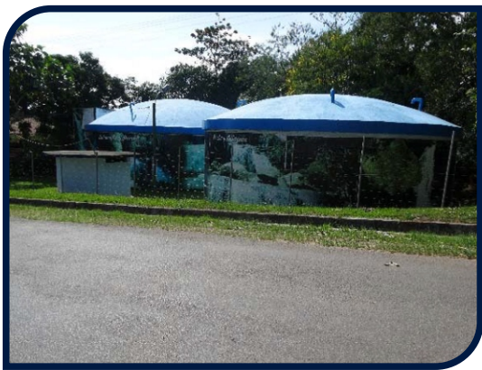
Reservorio Sistema San Mateo
