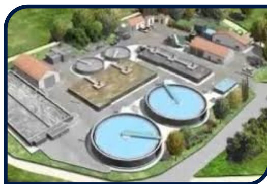
Planta de Lodos activados
