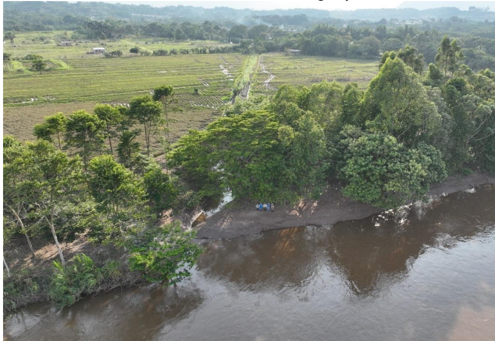
Foto N°32: Vista panorámica de la zona de captación y entorno natural del sistema de agua potable.
