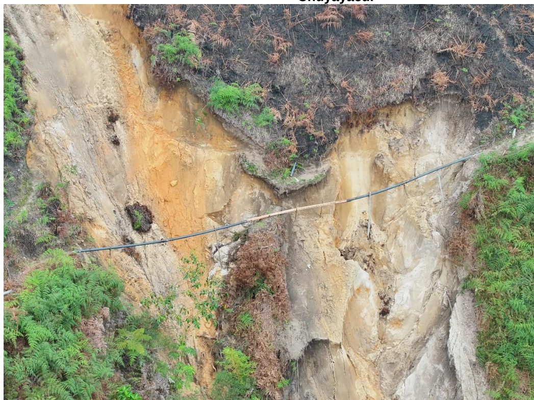
Foto N°18: Evaluación de integridad mecánica en sección crítica: Captación Chuyayacu.
