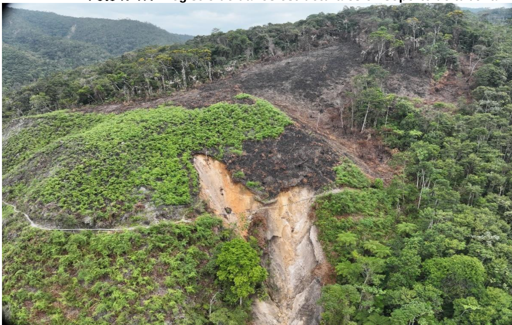
Foto N°17: Registro de daños estructurales en soporte de tubería
