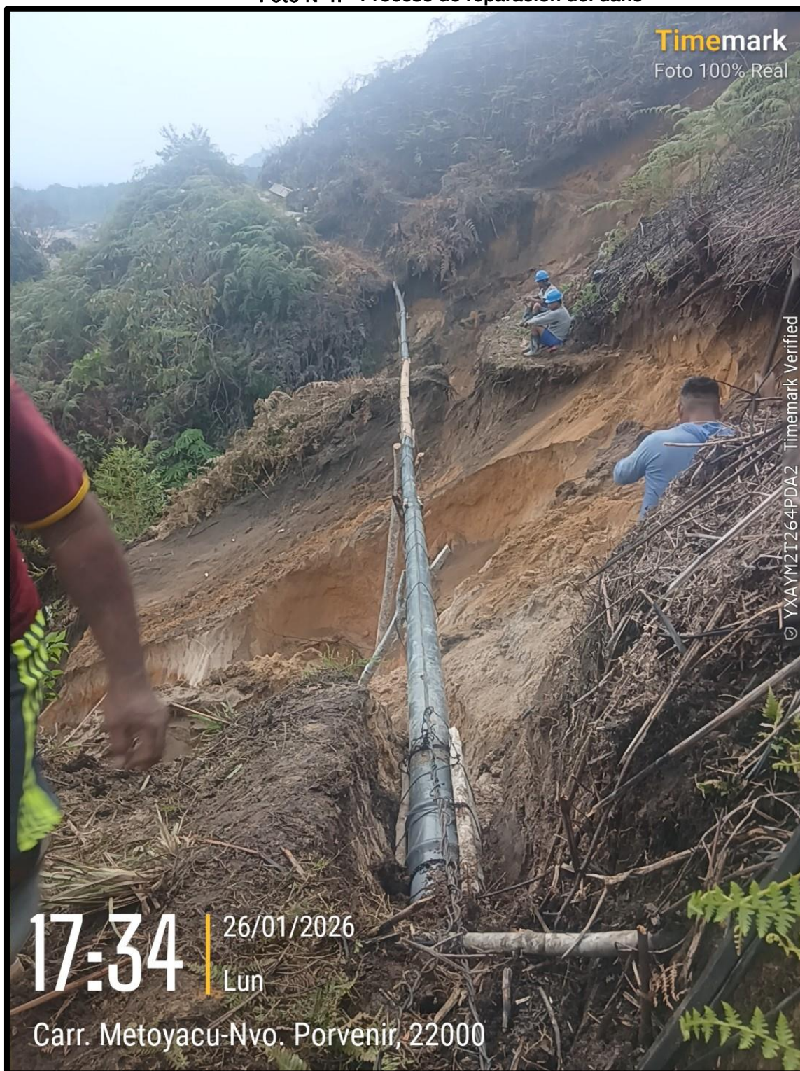
Foto N°4: Proceso de reparación del daño
