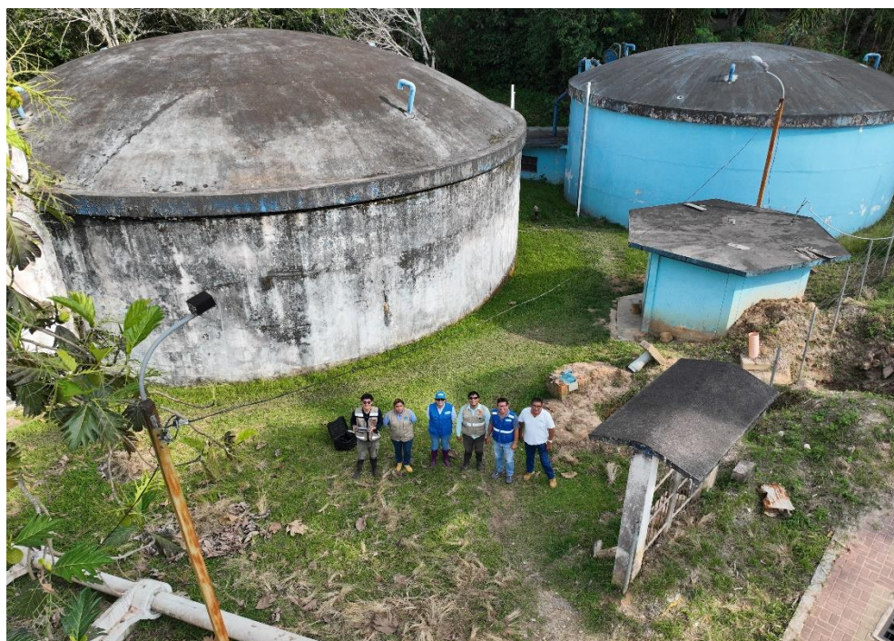
Foto N°30: Vista general de la zona de intervención
