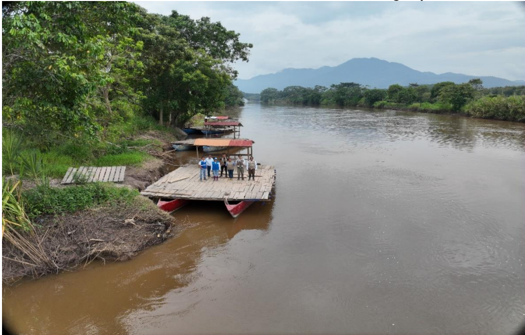
Foto N°11: panorámica del punto de captación superficial en el río Mayo para el sistema de abastecimiento de agua potable
