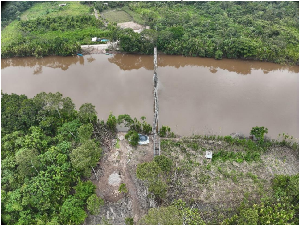
Foto N°14: Vista aérea del cruce de tubería sobre el río en el sistema de captación
