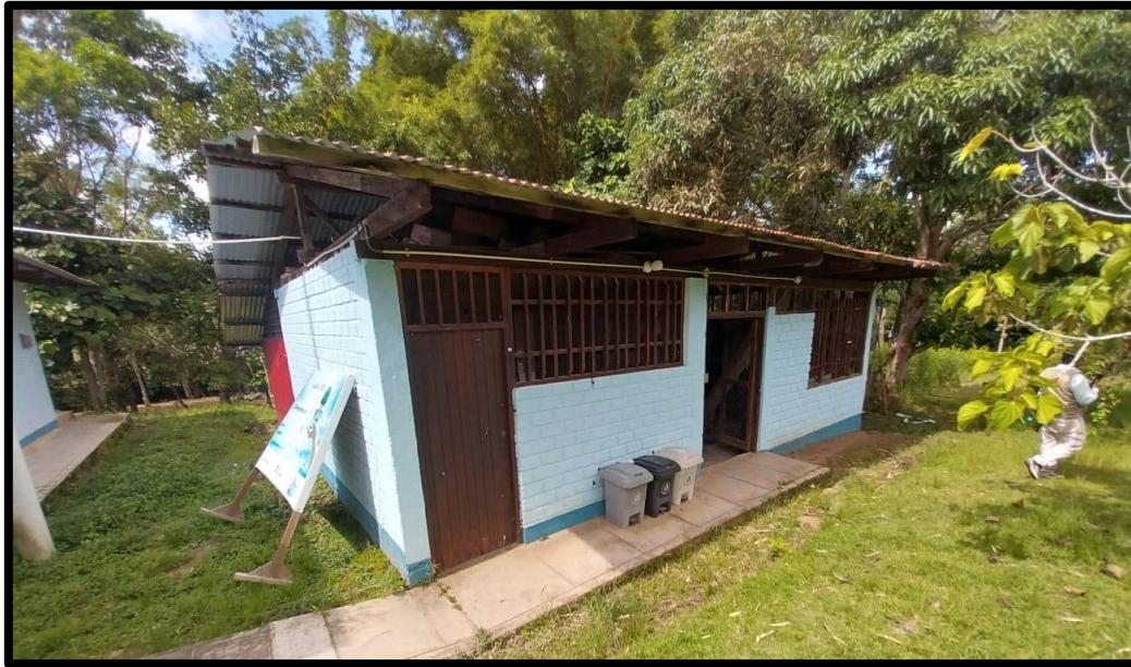
Foto N°8: Almacén de elementos variados
