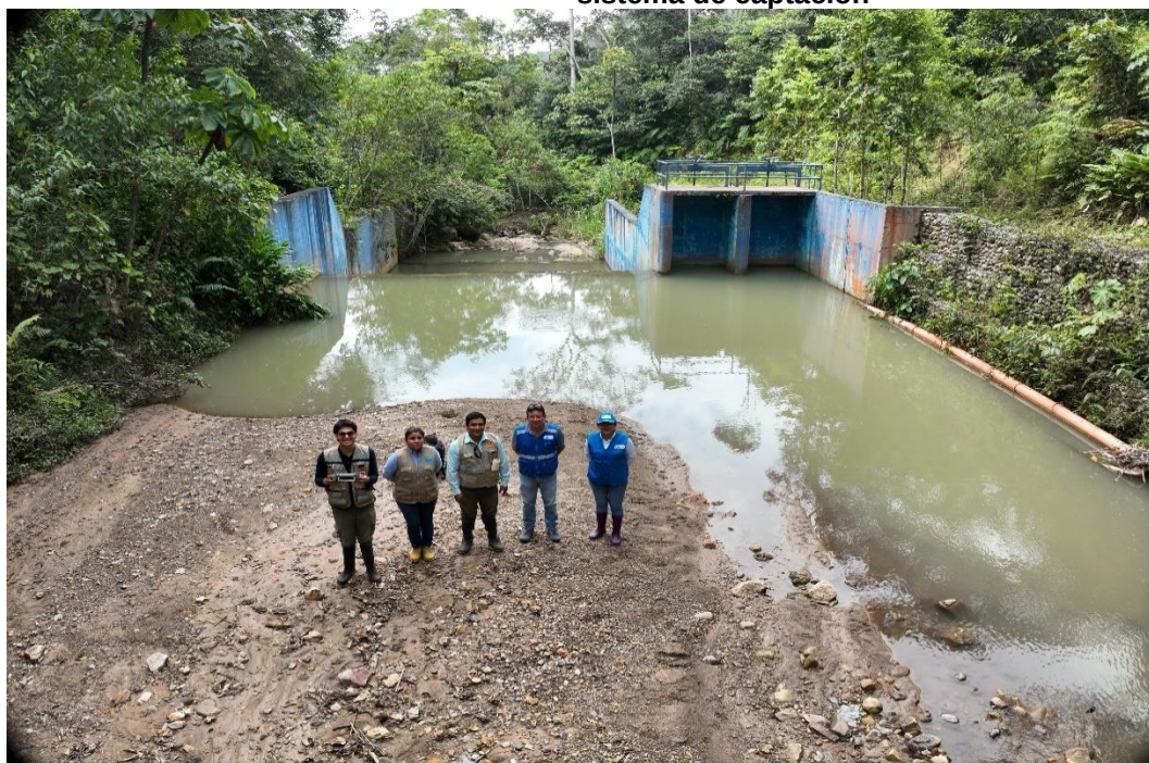
Foto N°28: Zona de acceso y mantenimiento de infraestructura hidráulica del sistema de captación
