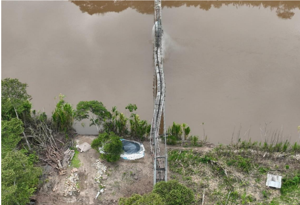
Foto N°13: Tramo de estructura metálica de soporte de tubería en el cruce del río para la conducción de agua cruda.
