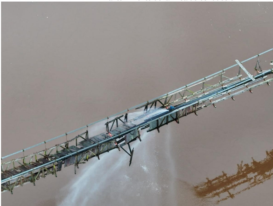
Foto N°12: Infraestructura de captación y pasarela de acceso para la operación y mantenimiento de la línea de conducción.
