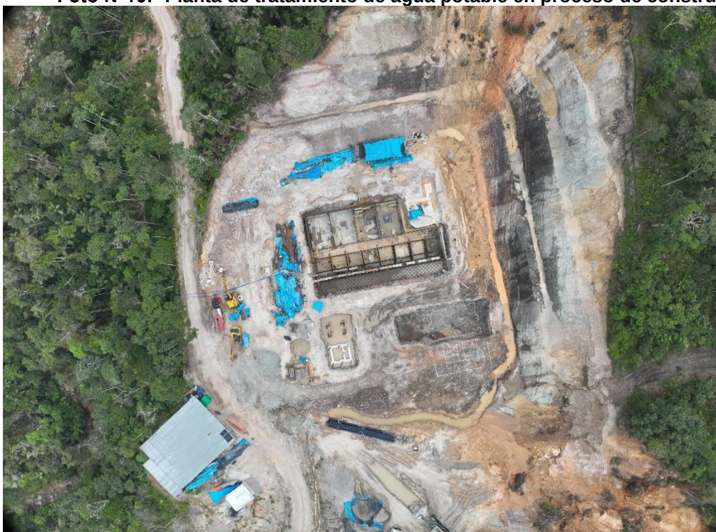
Foto N°16: Planta de tratamiento de agua potable en proceso de construcción
